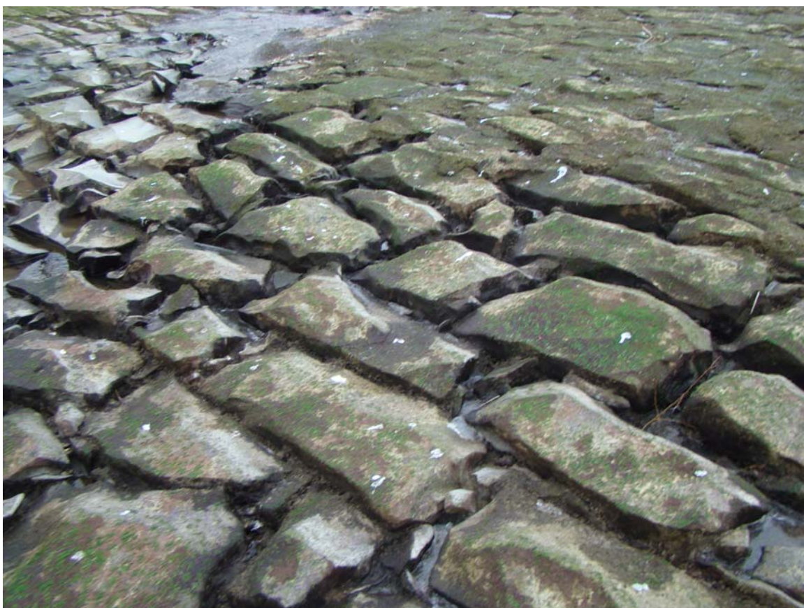
7. Przykład niszczącego działania rumowiska rzecznoego na okładzinę kamienną
