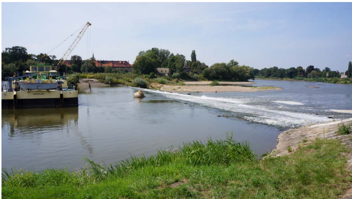
1. Widok jazuj Górnego od wody górnjej
