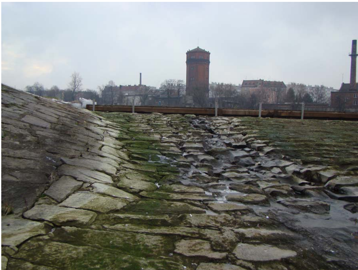
7. Przykład niszczącego działania rumowiska rzecznoego na okładzinę kamienną
