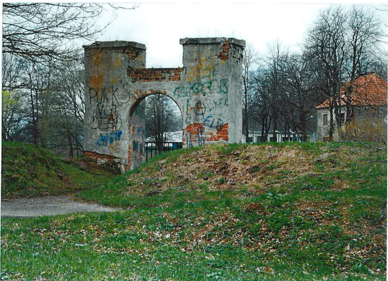
Fot.2. Pylon kładki pieszej prawego nadbrzeża. Widok całości obiektu w kontekście użytkowania przyległego terenu.
