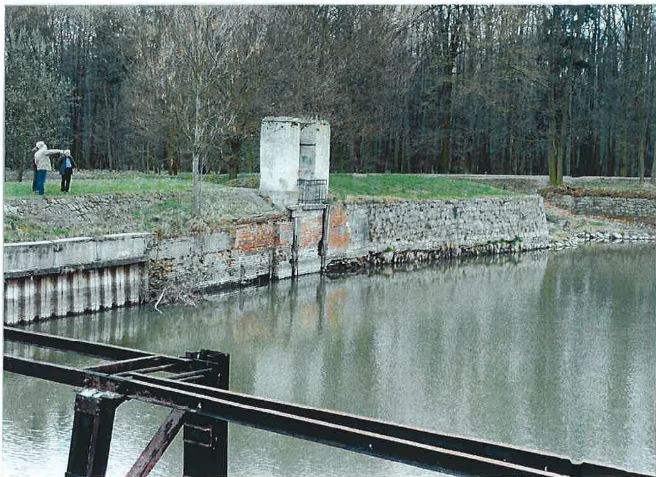
Fot.4. Pylon kładki pieszej prawego nadbrzeża. Widok całości obiektu usytuowanego w kontekście brzegu rzeki i przyległego terenu.
